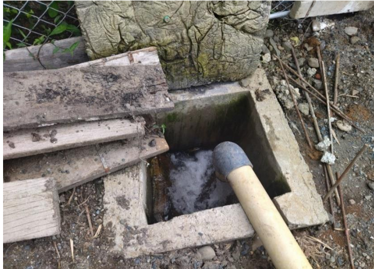
Imagen 27. Punto de descarga Zanjón Villegas
