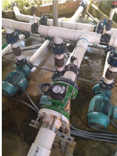
Imagen 15. Macromedidor salida PTAP
