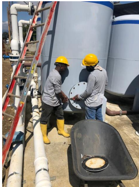
Imagen 10. Mantenimiento Filtros PTAP
