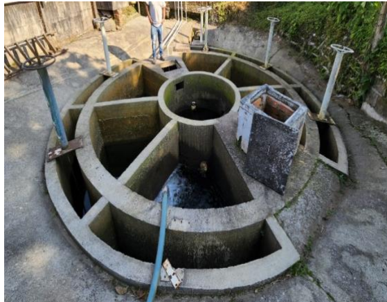
Imagen 10. Filtración de flujo ascendente y punto de aplicación de hipoclorito.
