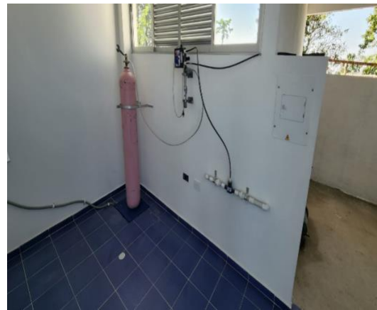
Imagen 11. Mecanismos dosificadores de hipoclorito
