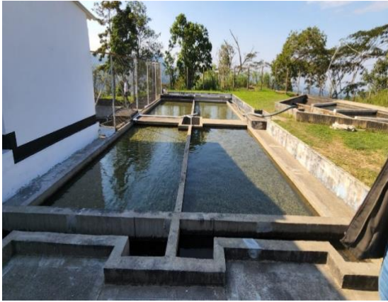
Imagen 10. Filtración de flujo ascendente y punto de aplicación de hipoclorito.
