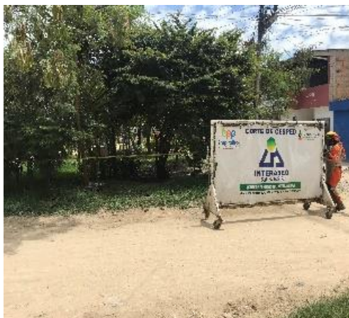
Malla de protección y aviso informativo.
