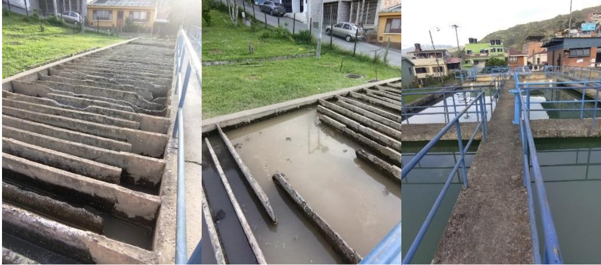
Imagen 9. Módulo de floculación y sedimentación
