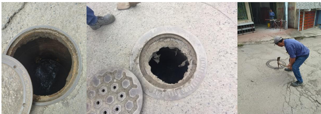
Imagen 15. Pozos de inspección
