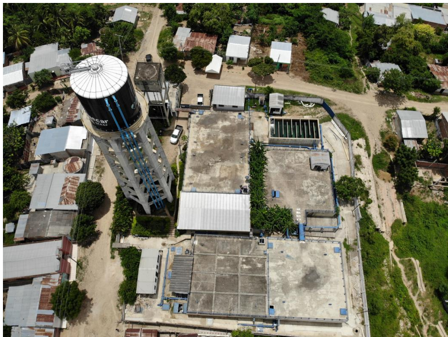
Fotografía 9. Planta de tratamiento de agua de ACUECAR S.A. E.S.P.
