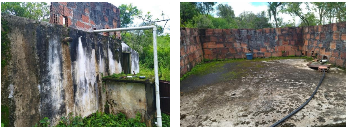
Imagen 10. Tanque de almacenamiento urbano
