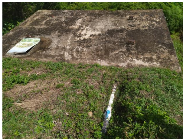
Imagen 9. Tanque de almacenamiento 3
