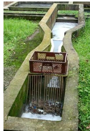
Imagen 4: Desarenador y canal de distribución.
