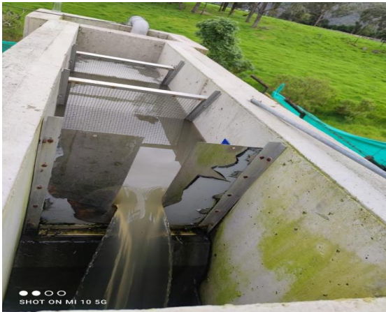
Sedimentadores de alta tasa secundarios
