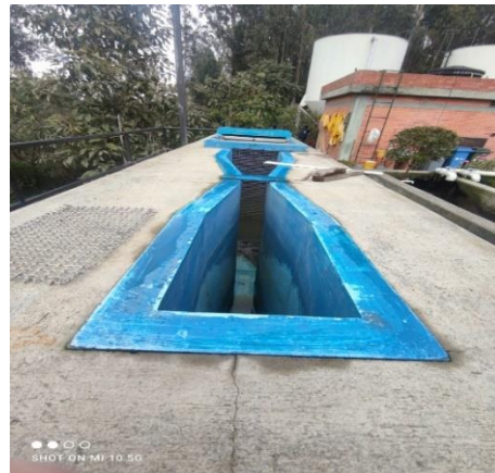
Estructura de Aforo o canaleta parshall
