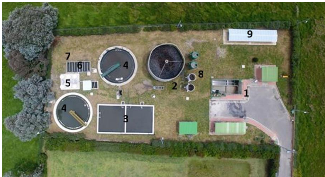
Imagen 5. Vista general PTAR Canavita
