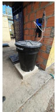
Sistema de inyección de peróxido de hidrógeno
