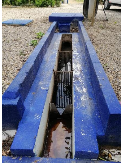
Ilustración 2. Emisario final y rejillas de cribado
