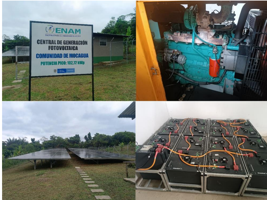
Figura 32 Registro Fotográfico Localidad Mocagua
