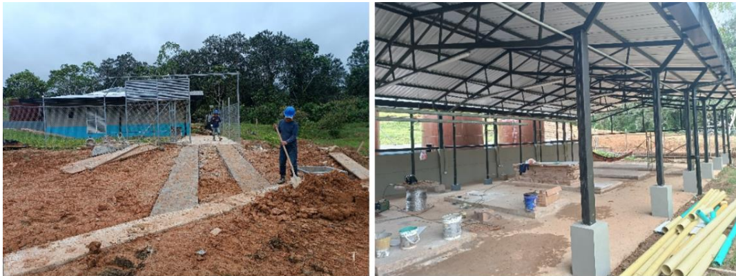
Figura 22 Registro Fotográfico Cerramiento y casa de máquinas
