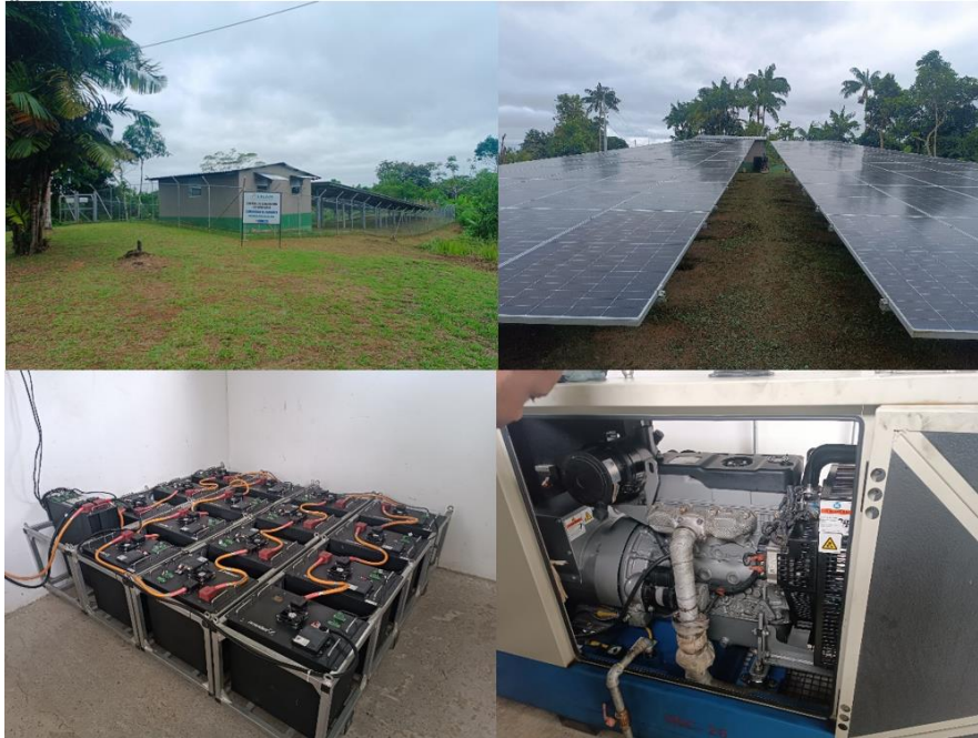
Figura 27 Registro Fotográfico Localidad Zaragoza
