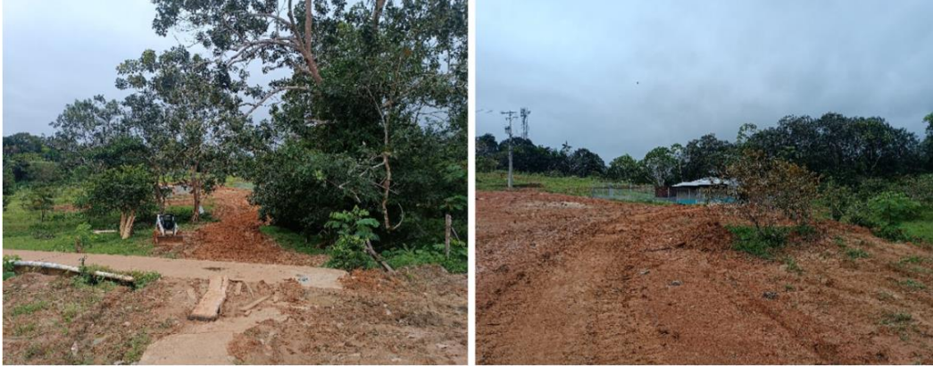
Figura 21 Registro Fotográfico Acceso a nueva central de generación
