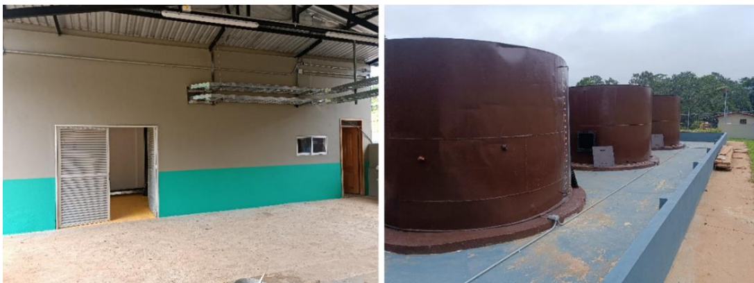
Figura 23 Registro Fotográfico Cuartos de potencia y control y almacenamiento
