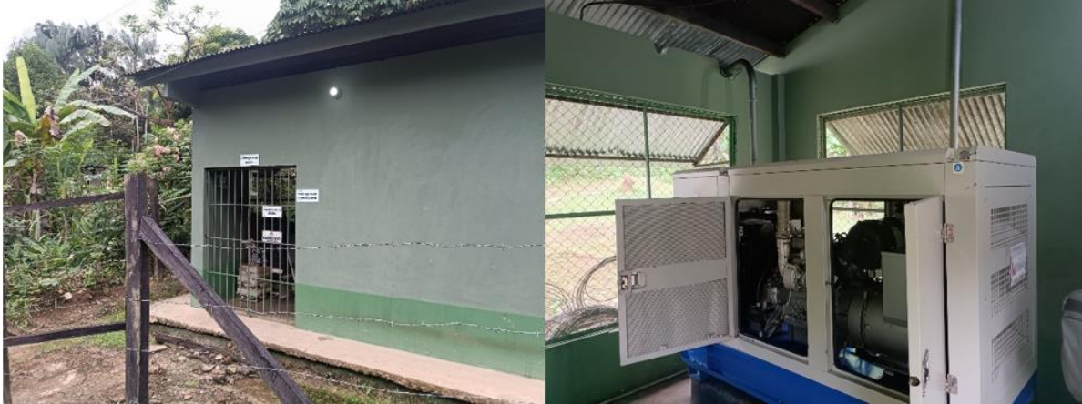
Figura 29 Registro Fotográfico Localidad Macedonia
