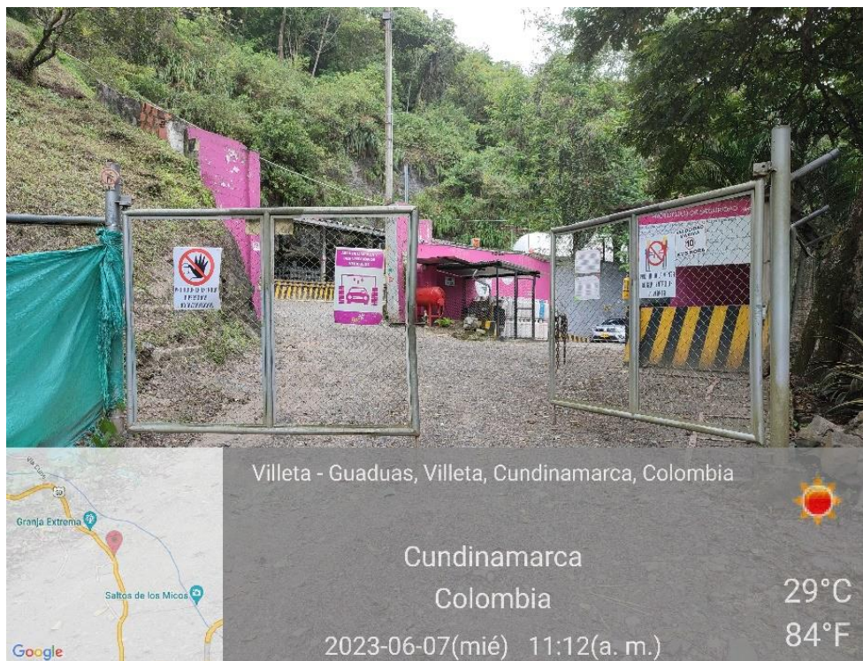
Figura 3. Fotografías instalación física de la Planta de Envasado CLC S.A.E.S.P. – Villeta, Cundinamarca
