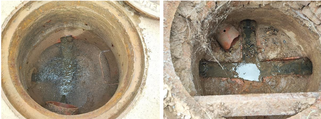
Imagen 16. Pozos de inspección alcantarillado
