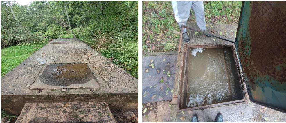
Imagen 7. Desarenador “La Honda”
