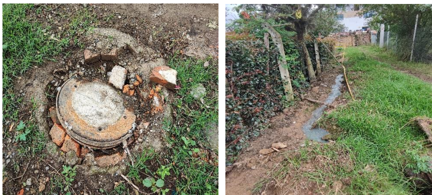
Imagen 18. Pozos de inspección alcantarillado
