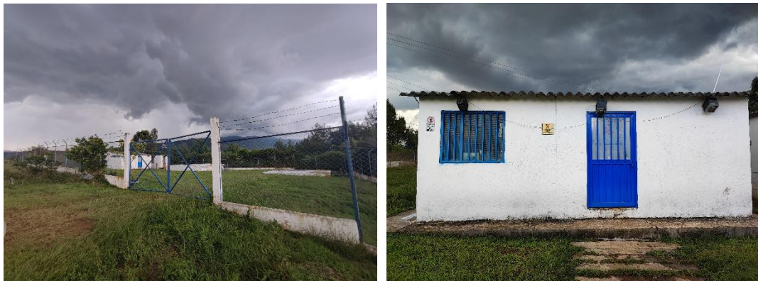
Imagen 10. Vista General de la PTAP
