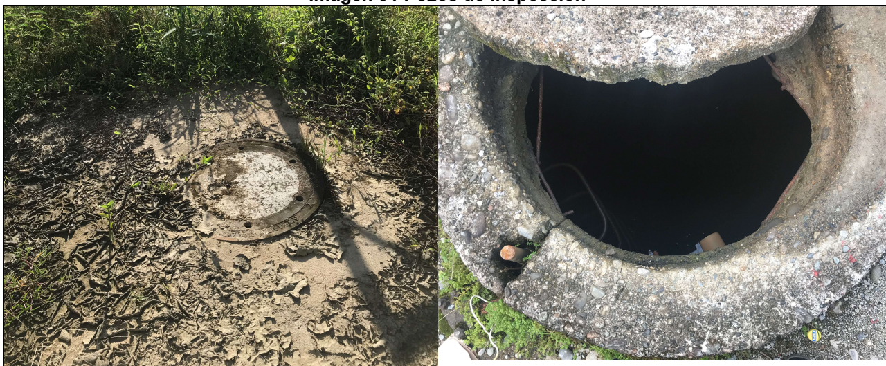
Imagen 31 Pozos de inspección
