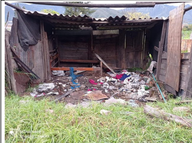
Calle 8 con carrera 11 – Barrio La Florida
