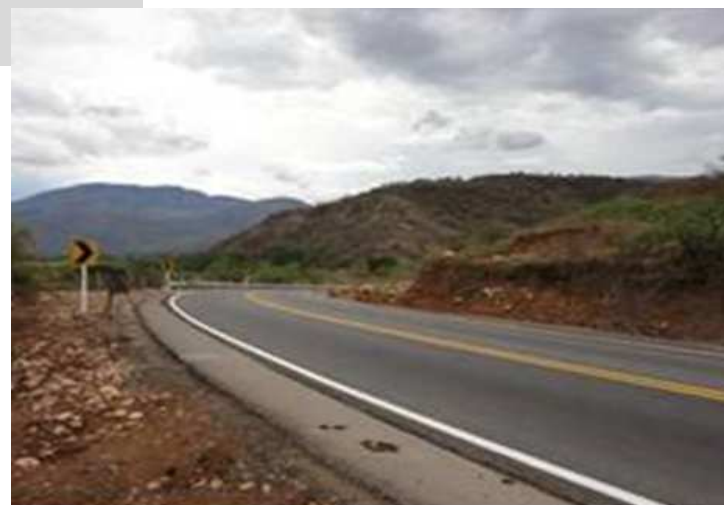
Carretera de la Soberanía y Transversal de la Macarena
