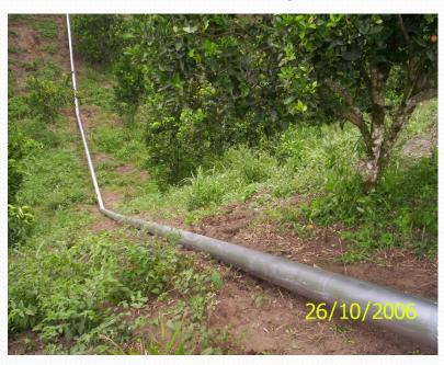
Reposición tubería PVC por Acero al Carbono en línea de aducción. (6,100 mts)
