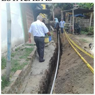
Reposición tubería de AC por PVC en su totalidad en red de conducción, distribución y domiciliaria. (34,000 ml)
