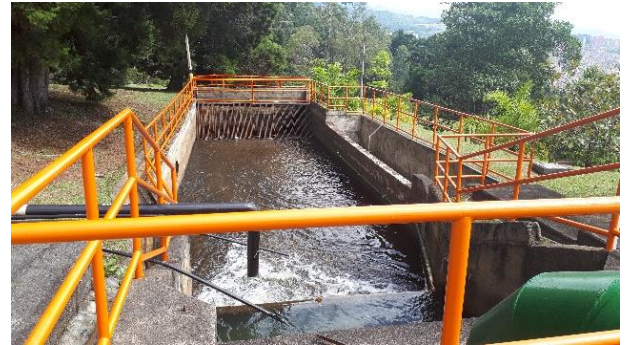
Estructura de entrada.
