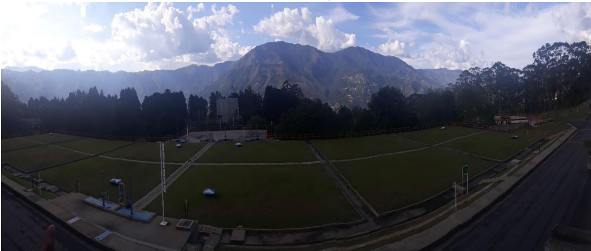
Tanques contacto de cloro
