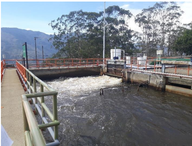
Ingreso a la PTAP
