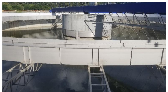
Sedimentador secundario (Detalle)
