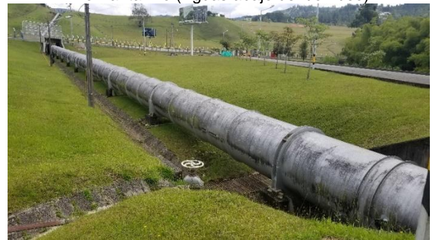
Tubería de aducción
