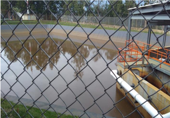
Laguna de homogenización
