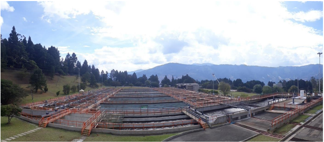
Imagen 15. Vista general PTAP Manantiales
