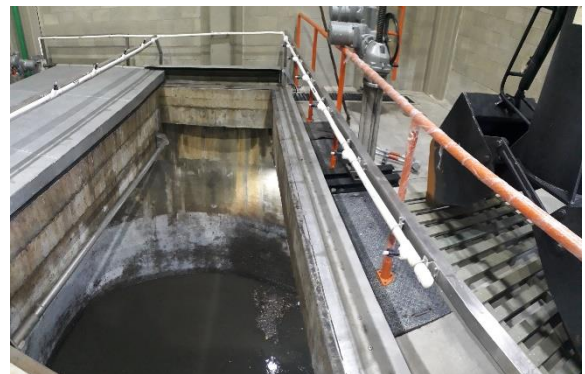
Pozo de ingreso
