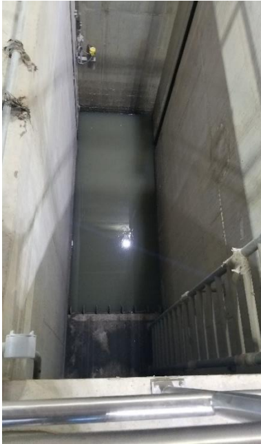
Reja principal a la entrada de la PTAR
