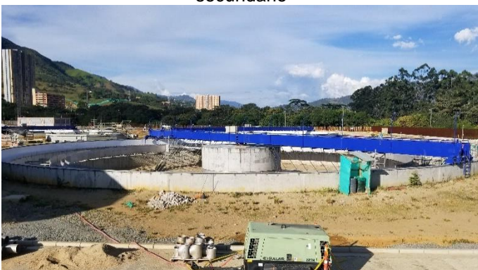
Sedimentador secundario
