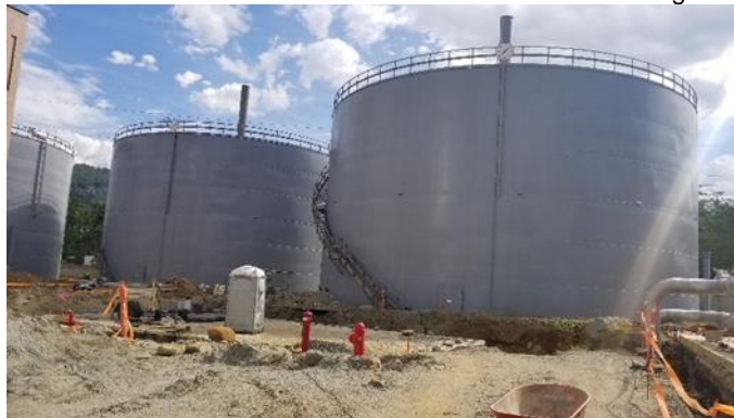
Tanques de almacenamiento de biogás Fuente: Registro fotográfico SSPD
