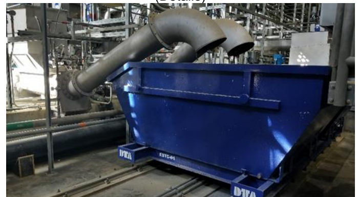
Disposición de basuras removidas durante el cribado
