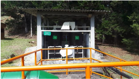
Preparación y aplicación de carbón activado
