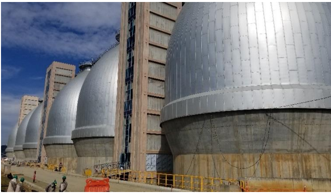
Digestores anaeróbicos
