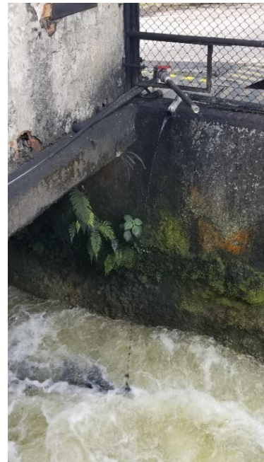
Punto de aplicación de carbón activado
