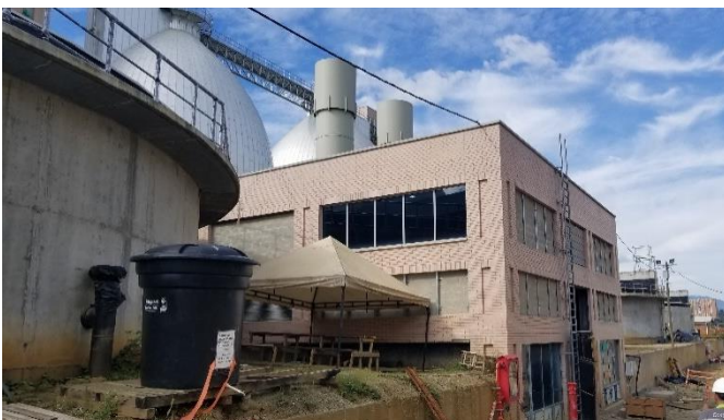
Edificio de control de olores
