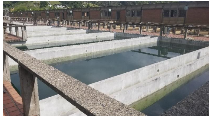
Unidades de floculación / sedimentación
