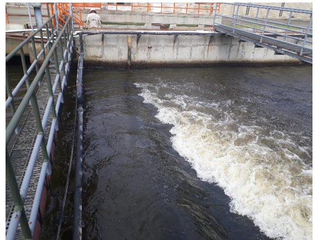
Resalto hidráulico y dosificación de Coagulante
