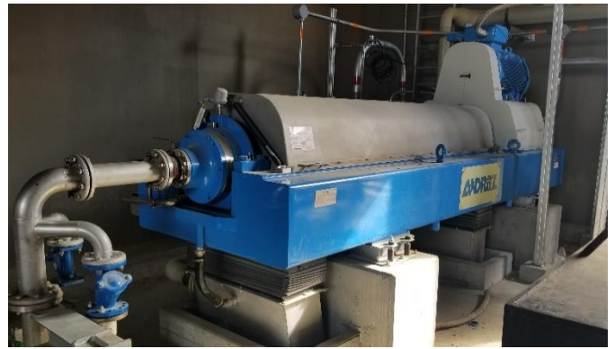
Centrífuga de deshidratación
