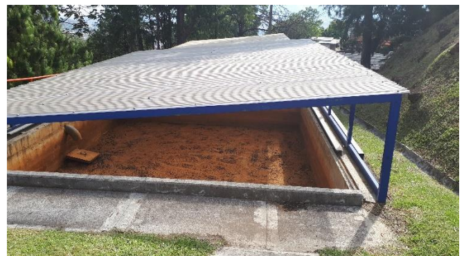
Secado de lodos
