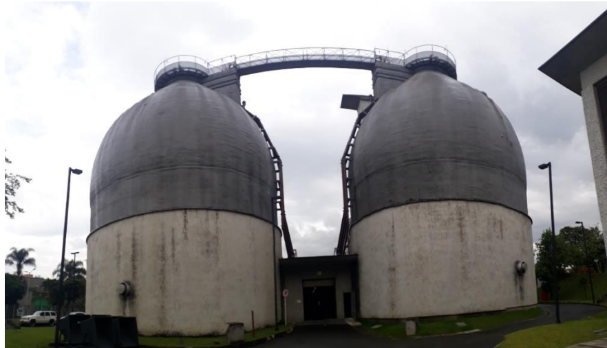
Digestores anaeróbicos
