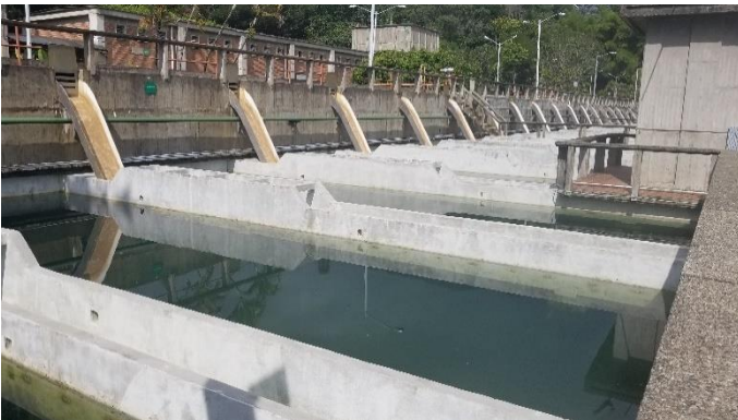
Unidades de floculación / sedimentación
