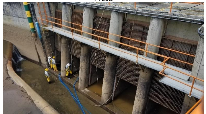
Captación de agua para el bombeo
