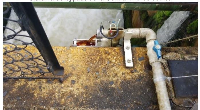
Punto de aplicación de coagulante
