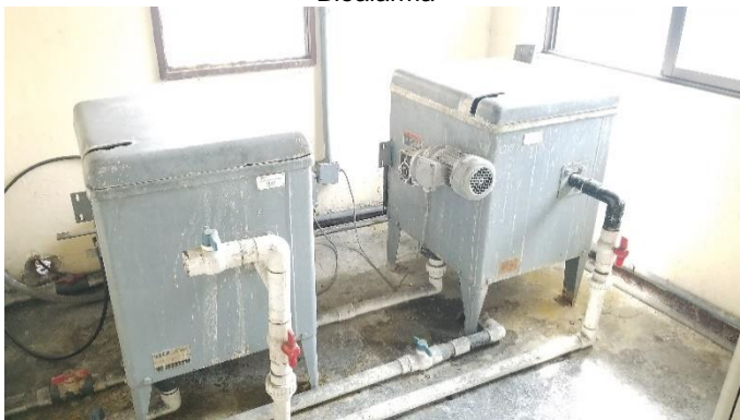
Sistema de dosificación de coagulante
