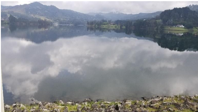
Embalse La Fe (Vista desde la presa)
