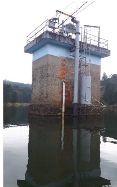
Torre de captación
