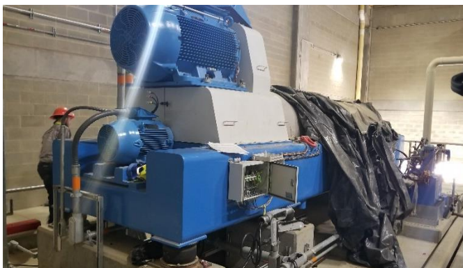
Centrífuga de espesamiento
