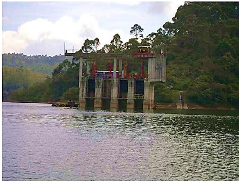
Imagen 13. Torre de captación Riogrande
