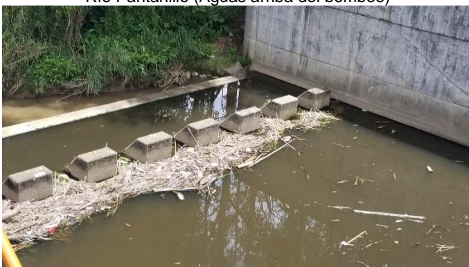
Estructura de disipación de energía
