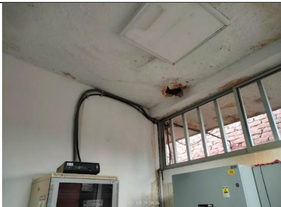
**Ilustración 23. Indicios de goteras – Caseta de control**
