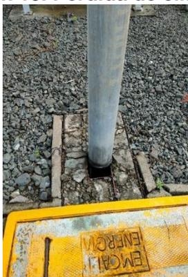
**Ilustración 15. Acero estructural visible en postes de pórticos**
