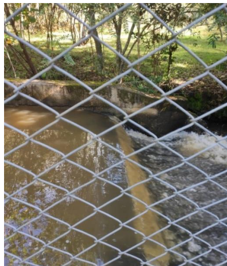
Imagen 7. Captación – Quebrada la Cebada
