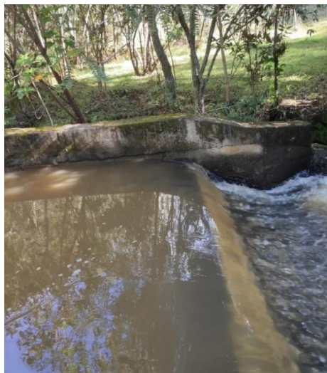
Imagen 6. Captación – Quebrada la Cebada
