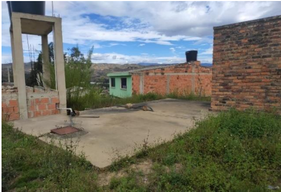
Imagen 39. Tanque de Almacenamiento 3
