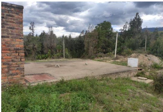
Imagen 37. Tanque de Almacenamiento 2
