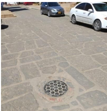
Imagen 62. Pozo de inspección
