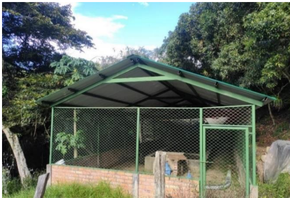
Imagen 10. Cerramiento desarenador
