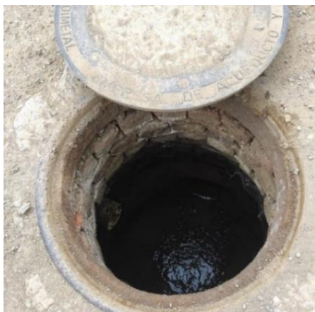
Imagen 60. Pozo de inspección
