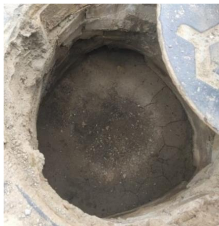
Imagen 61. Pozo de inspección
