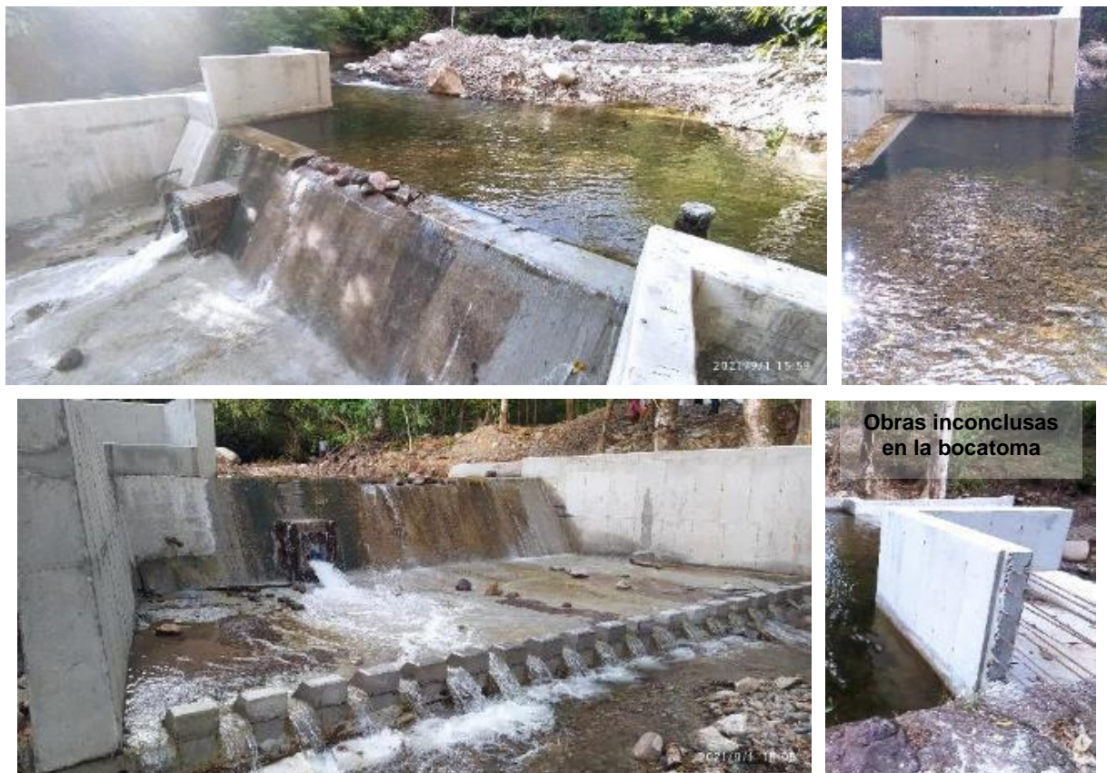
Imagen 12 Estado actual obra de captación sobre la quebrada Canoítas (Ataco, Tolima)
