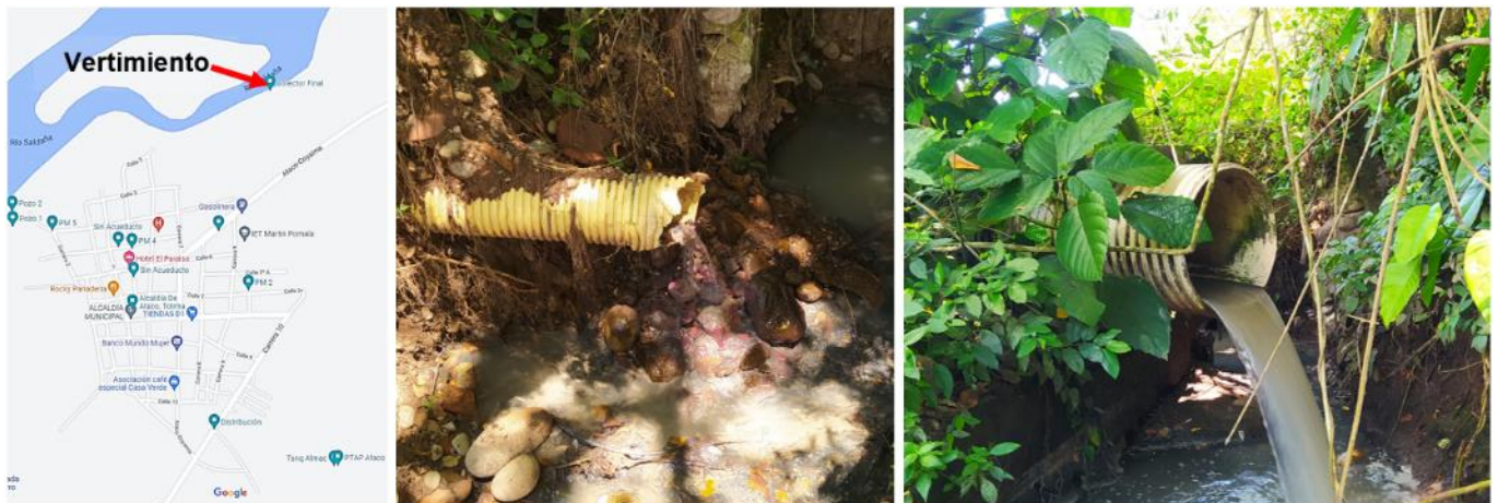
Imagen 38 Punto de descarga de aguas residuales del alcantarillado sanitario urbano de Ataco, Tolima
