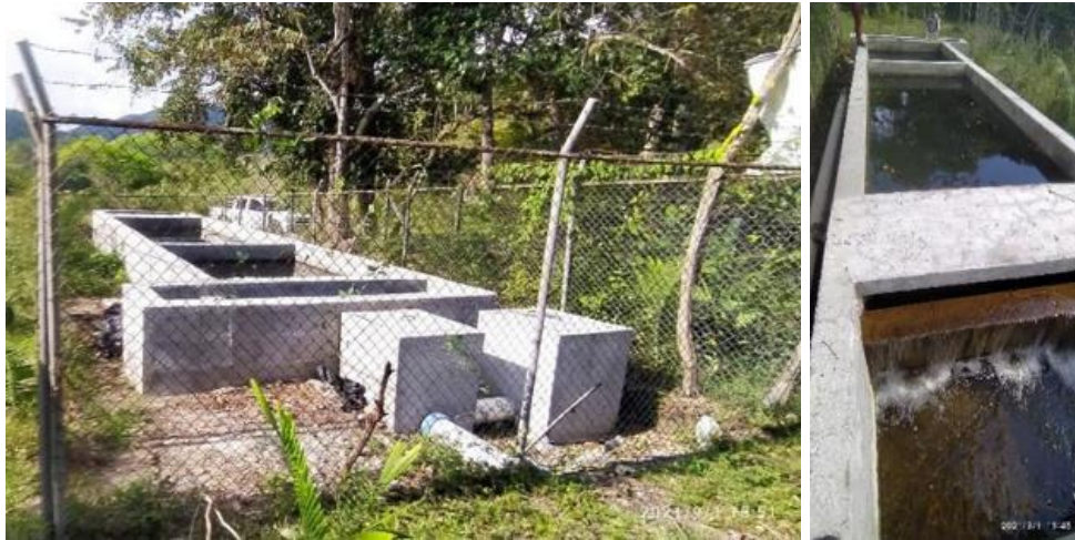
Imagen 17 Estado actual del desarenador del acueducto urbano de Ataco, Tolima.
