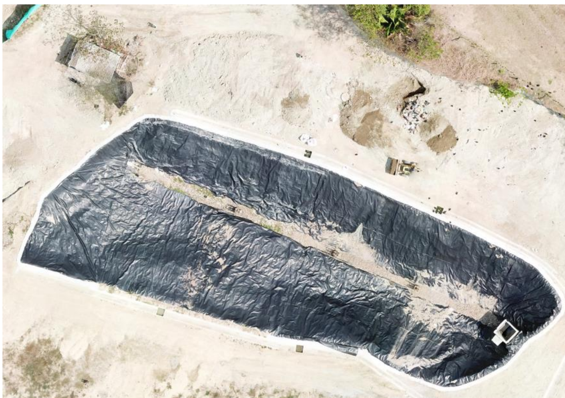
Ilustración 4. Celda de Contingencia (Provisional) - Puerto Triunfo, Antioquia.
