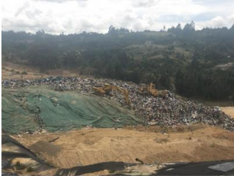
Ilustración 1. Relleno Sanitario PIRGUA – Tunja, Boyacá
