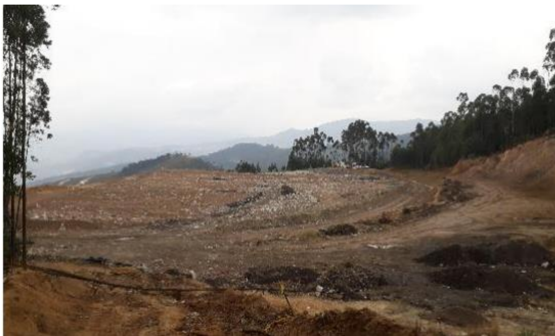
Ilustración 9. Relleno Sanitario Terrazas del Porvenir- Sogamoso, Boyacá.
