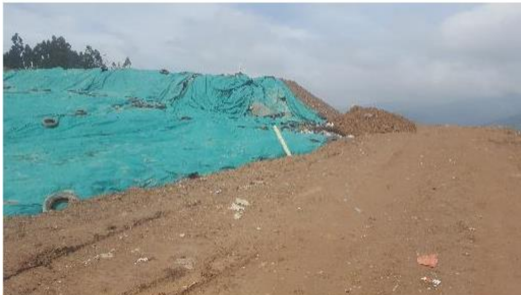
Ilustración 8. Relleno Sanitario Terrazas del Porvenir- Sogamoso, Boyacá.
