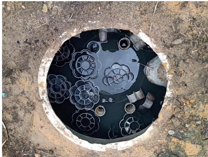
Imagen 11. Filtro anaerobio con lecho móvil
