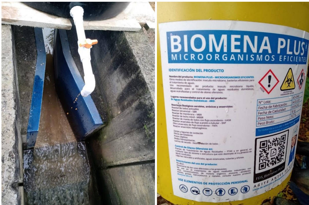
Fuente: SSPD – Visita de inspección 21 y 22 de abril de 2022
