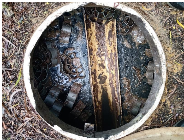
Imagen 8. Filtro anaerobio con lecho móvil
