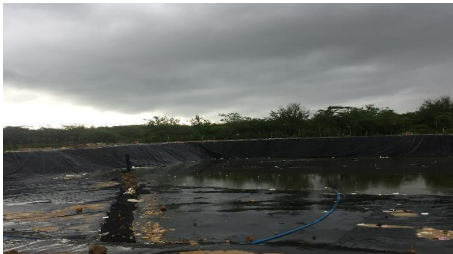
Imagen 12: Empozamiento de lixiviados en la celda actual de disposición
