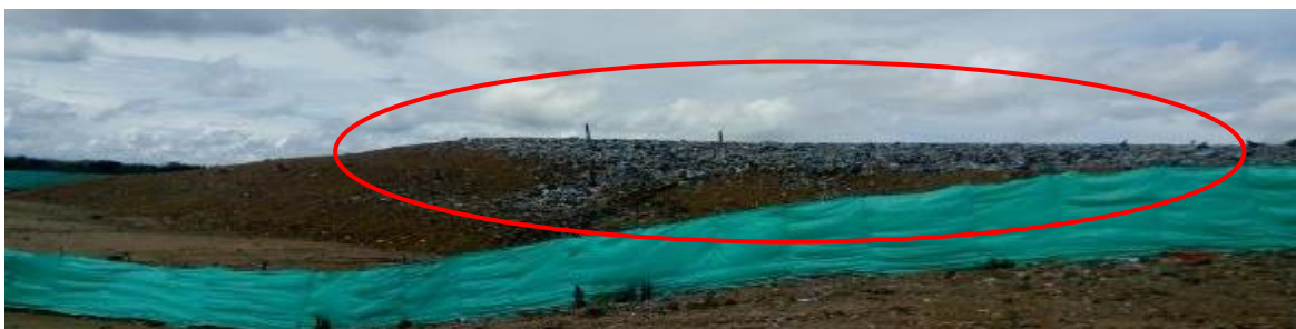
Imagen 16: Residuos sin cubrimiento – Celda en proceso de cierre
