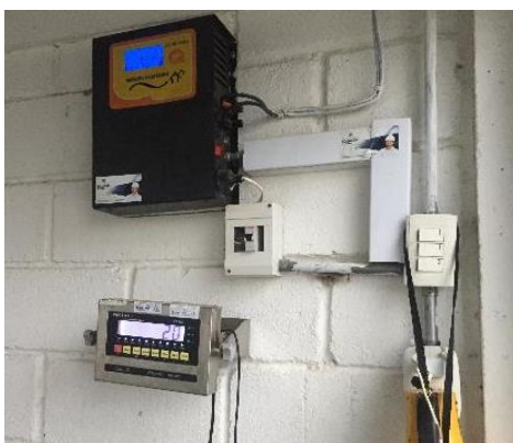
Fuente: Registro Fotográfico – Visita octubre 2018
