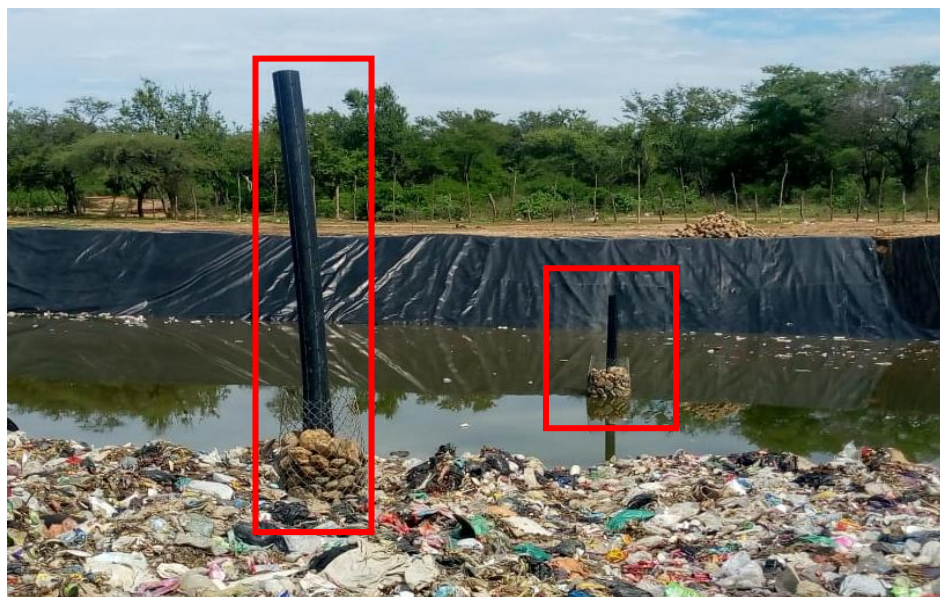
Imagen 25: Control de gases por medio de chimeneas
