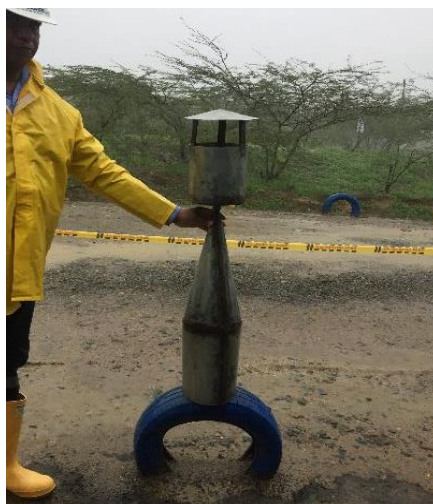
Imagen 26: Pipetas para la quema del gas
