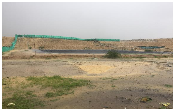
Imagen 23: Piscina de Lixiviados
