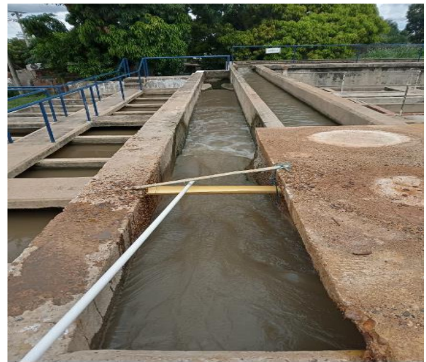
Imagen 26 Adición del coagulante
