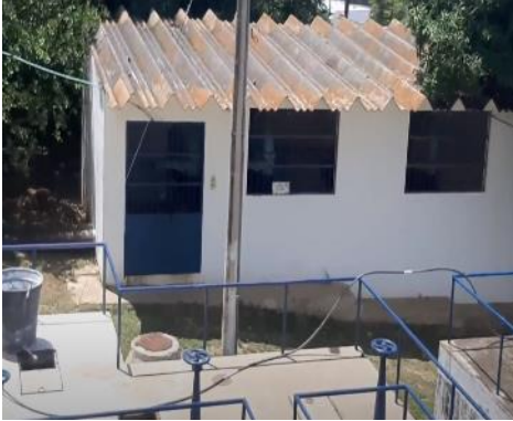
Imagen 38 Cuarto de máquinas - Equipos de bombeo
