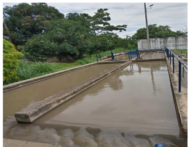
Imagen 24 Desarenador Sedimentación y Salida del desarenador
