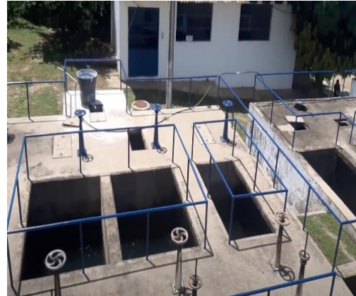
Imagen 32 Batería de filtro número dos
