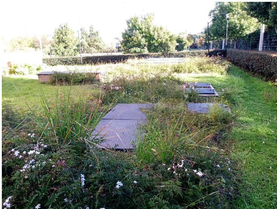
Imagen 10. PTAR Reserva de Moraverde
