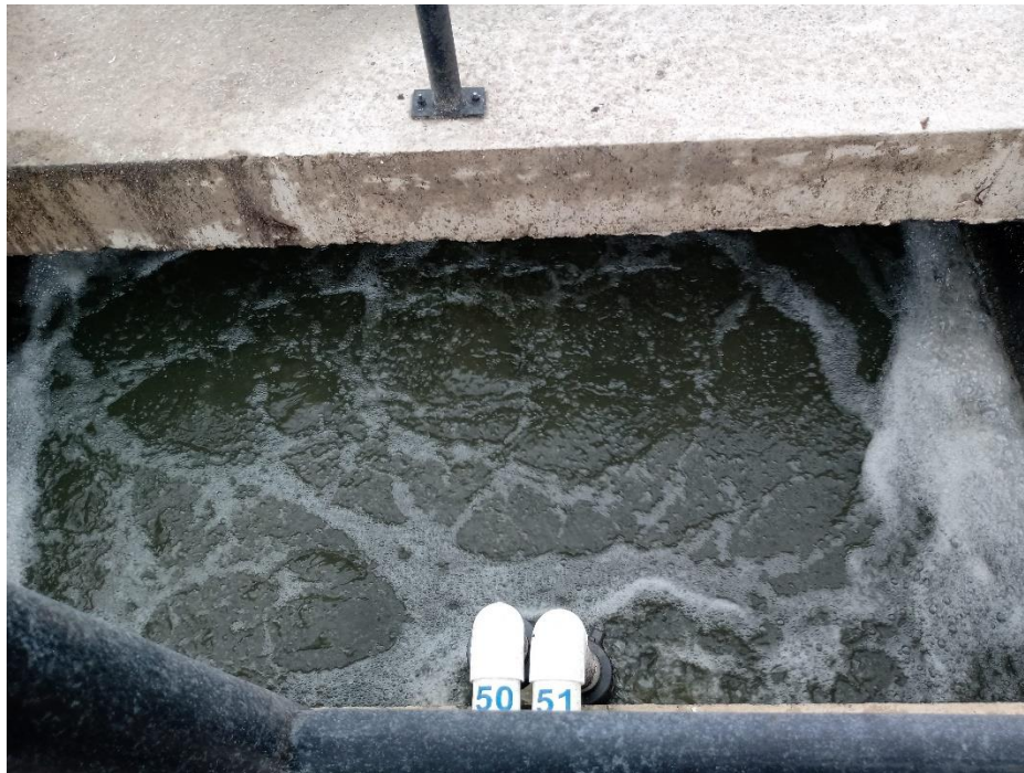
Imagen 13. Tanque de aireación
